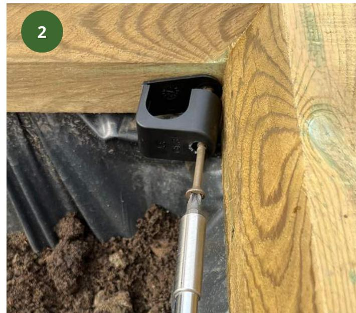
**Atornilla el soporte a la tapa:** atornilla el soporte de fijación en la cara interna de la tapa WoodBlocX.
