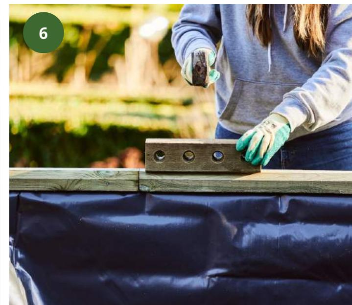
**Encaja las tapas con la maza:** usa un BlocX sobrante para no dañar las tapas. **¡Listo!**
