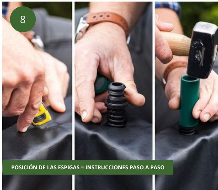
**Sujeta el forro con las espigas:** haz pequeñas incisiones para sujetar el forro con las espigas de la última fila.
