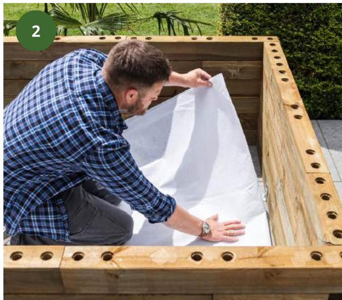
**Añade protección al suelo:** coloca una capa protectora de fieltro, una alfombra vieja o una tela geotextil debajo del forro del estanque para evitar pinchazos indeseados.
